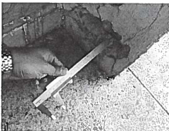
Foto 25 – Pilar 144 – Cobrimento 27mm
