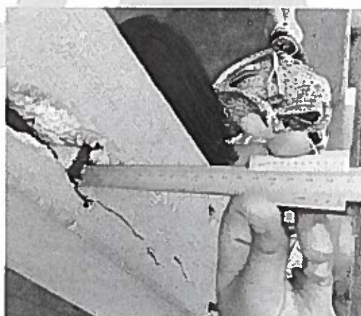
Foto 28 – Pilar 6 – Cobrimento 9mm
