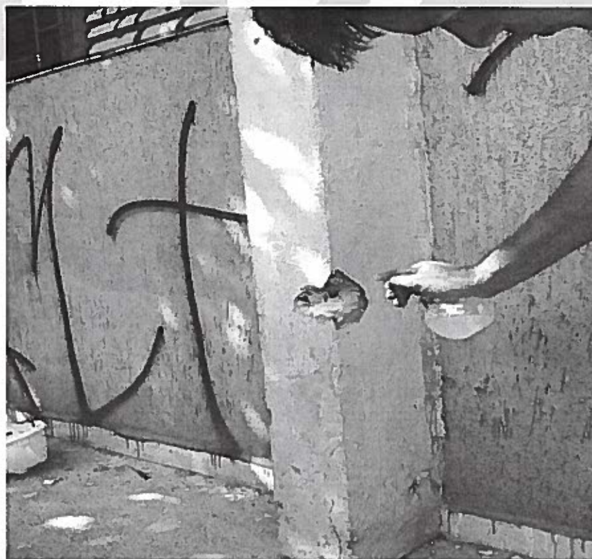
Foto 38 – Pilar 111 – Ensaio em execução
