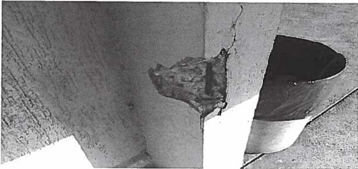
Foto 11 – Pilar 21 – Sem recobrimento
