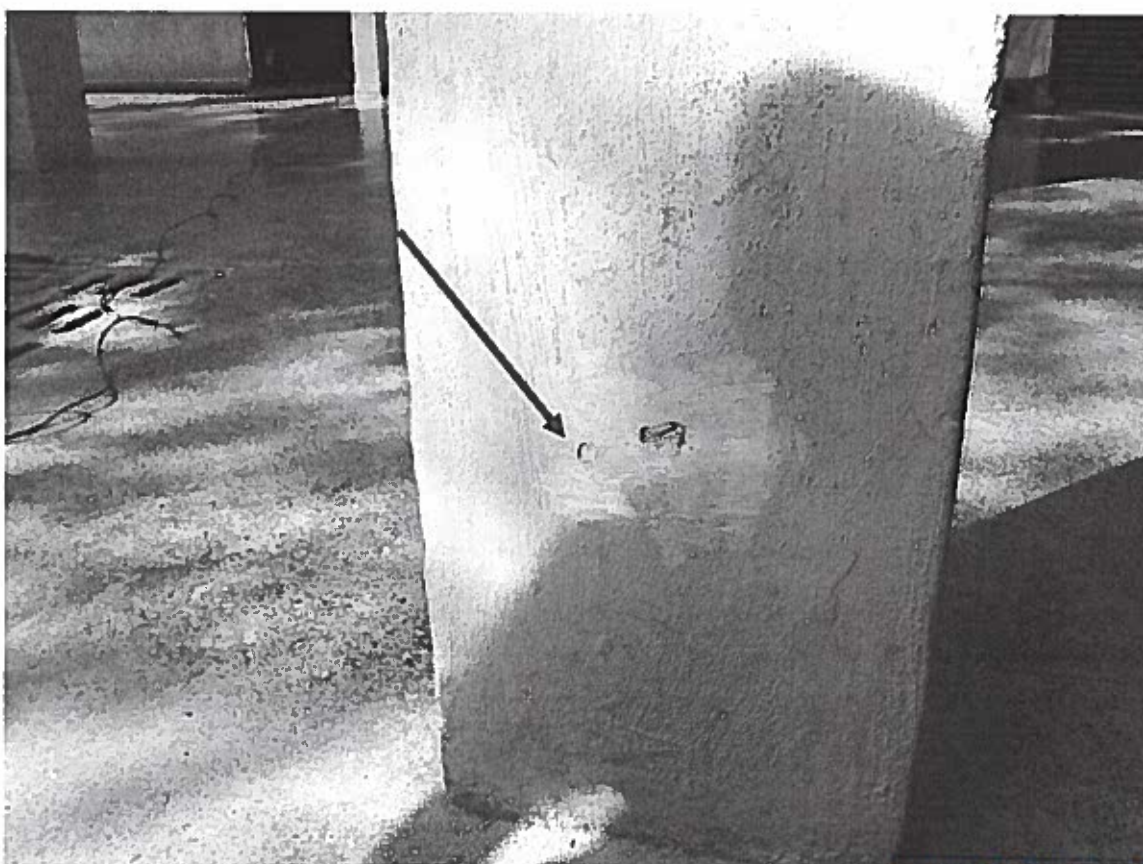
Foto 35 – Pilar 56 – Não pôde ser ensaiado – Índice < 20
