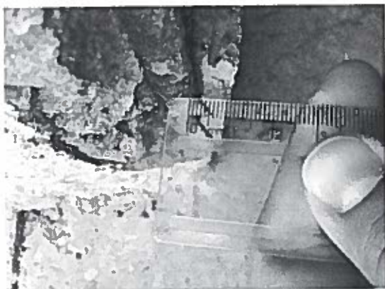
Foto 23 – Pilar 84 – Cobrimento 10mm
