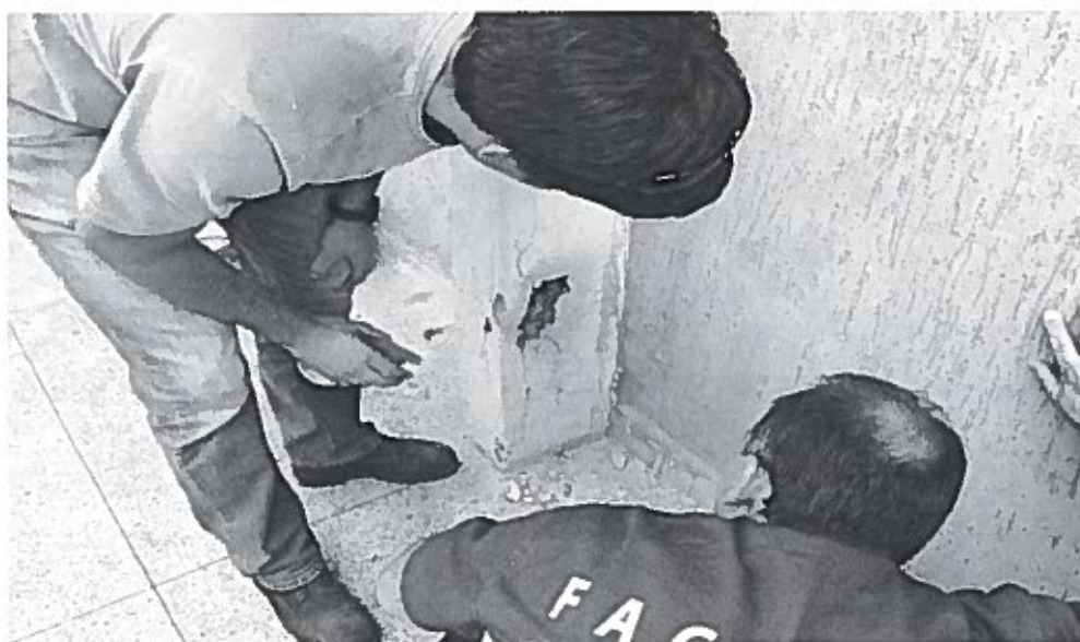
Foto 36 – Pilar 66 – Ensaio em execução
