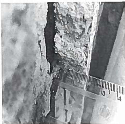
Foto 21 – Pilar 50 – Cobrimento 19mm
