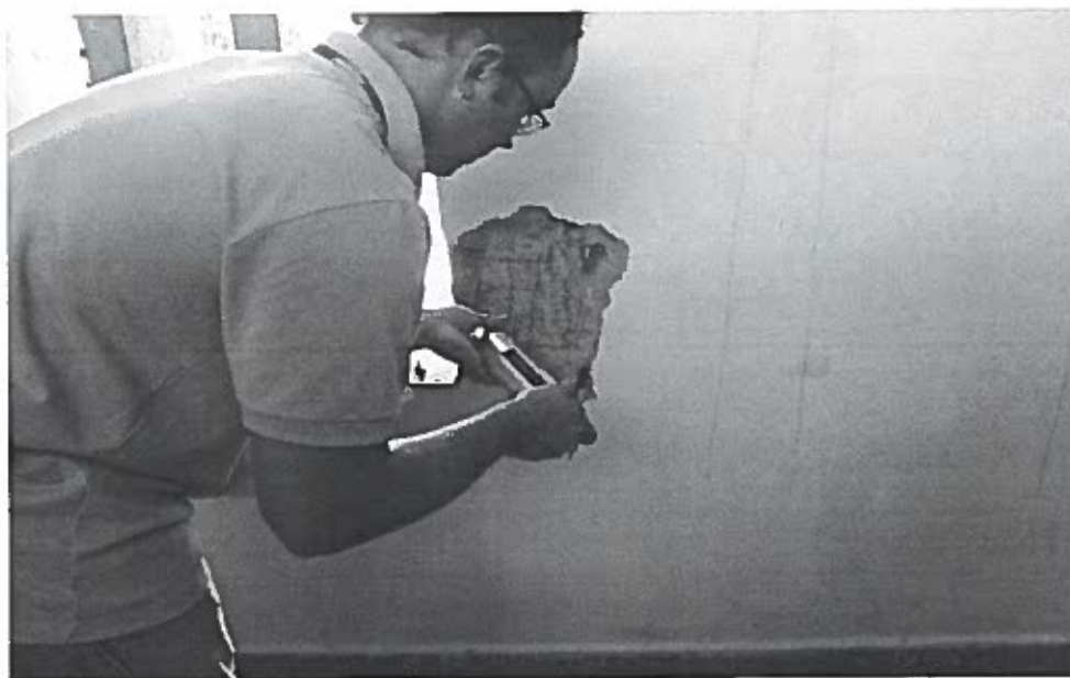
Figura 32 – Pilar 42 – Ensaio em execução
