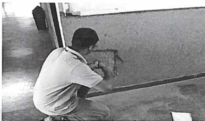
Figura 30 – Pilar 63 – Ensaio em execução
