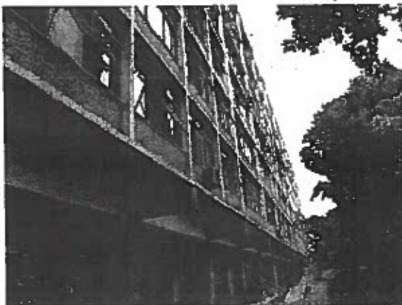
Foto 14 - Fachada do Prédio
