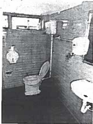
Foto 11 - Banheiro - Pav. Superior
