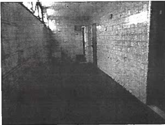
Foto 12 - Área de Serviço
