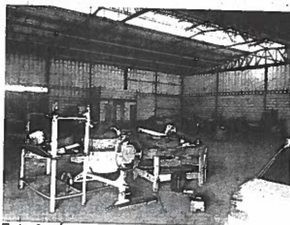
Foto 6 – Área interna do galpão
