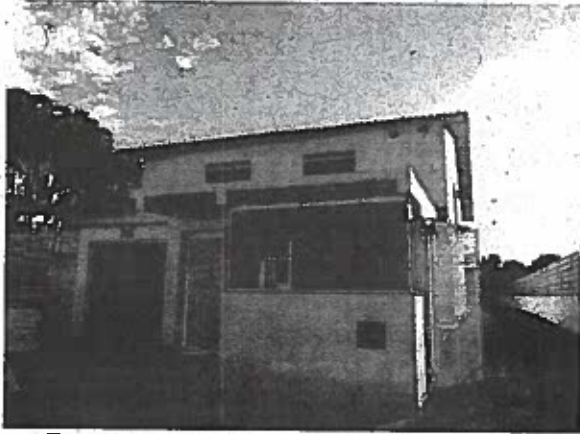
Foto 1 – Fachada e portão de entrada
