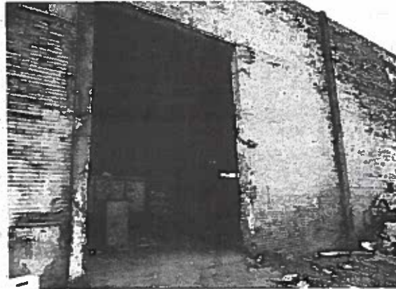
Foto 8 - Vista lateral direita
