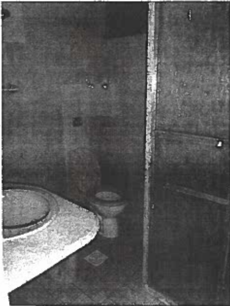
Foto 12 - Banheiro da suíte
