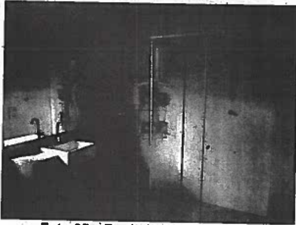
Foto 35 - Banheiro do Gabinete
